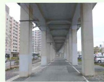
写真2 海岸に近い高架橋外観
