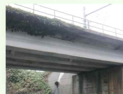
写真1 海岸沿いの橋梁外観
